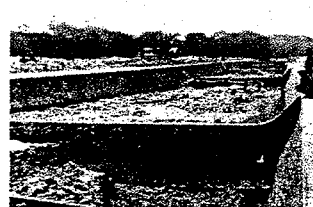
流路工施工後の昭和初期の逆瀬川
