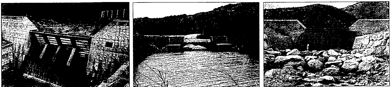
寫眞-1. 良好な状態の砂防ダム
