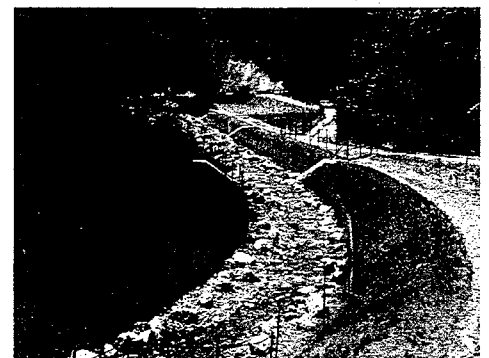
写真-2 復元水路（施工直後）
