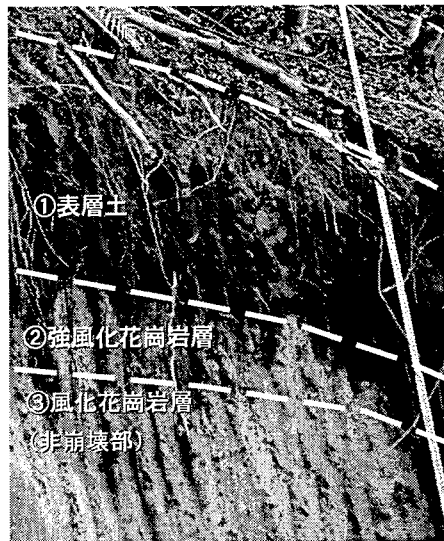
写真-1 崩壊部掘削断面状況
