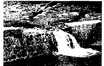
写真-5 堤体の浸食
