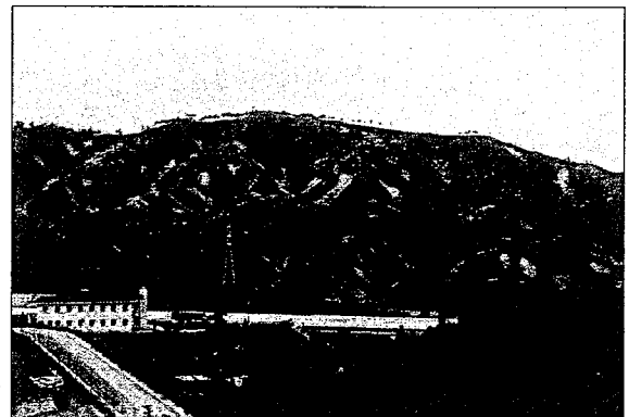
写真-1. 山崩れ跡地の全景
