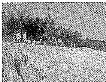
現場見学会（掘削時）
