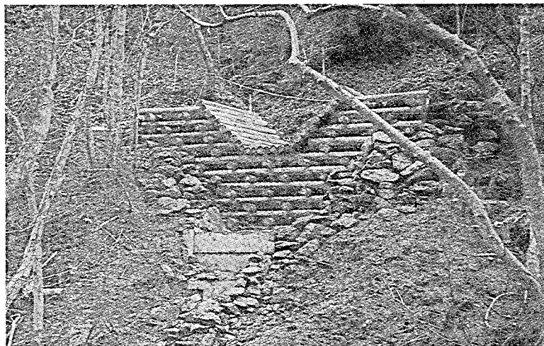
写真－1 完成した木製堰堤
