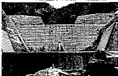
写真-4 目地間隔を10cmに仕上げた砂防ダム (黒色酸化鉄2%、明度5.5)
