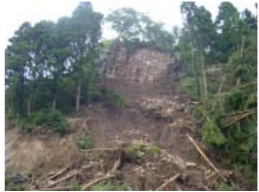
写真1 自然斜面の拡大崩壊タイプ
