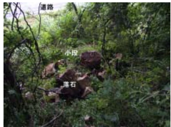
写真6 盛土された小段が落石を止めた例
