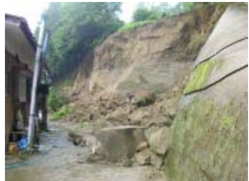
写真3 人工斜面の拡大崩壊タイプ
