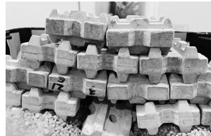
写真-2 観察されたブロック積砂防堰堤における屈撓性能等の状況
