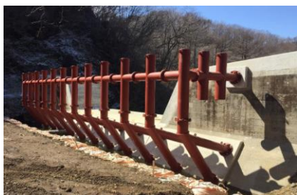
写真-1 張り出しタイプ流木捕捉工
