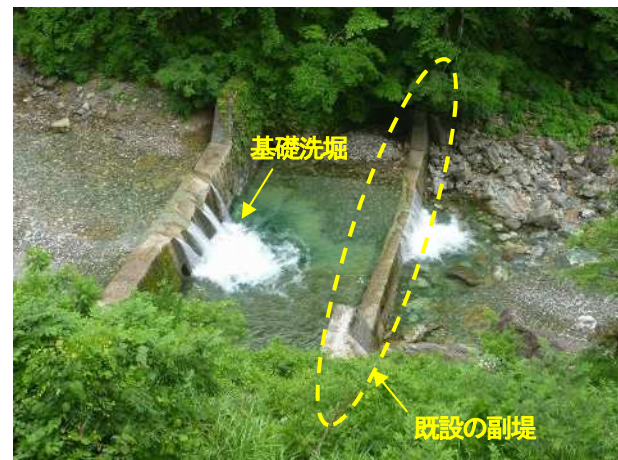
写真1 前庭保護工の補修 (施工中)
