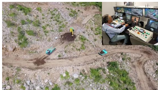
写真-1 AI制御による不整地運搬車の自動走行
