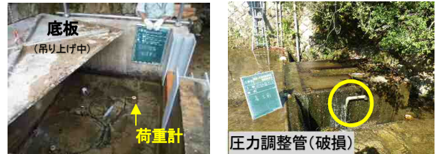
写真 1 ピット流砂計(底板式)
