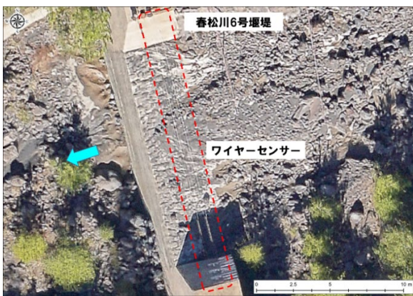
図. 4 オルソ画像（拡大）（春松川 6 号堰堤）
