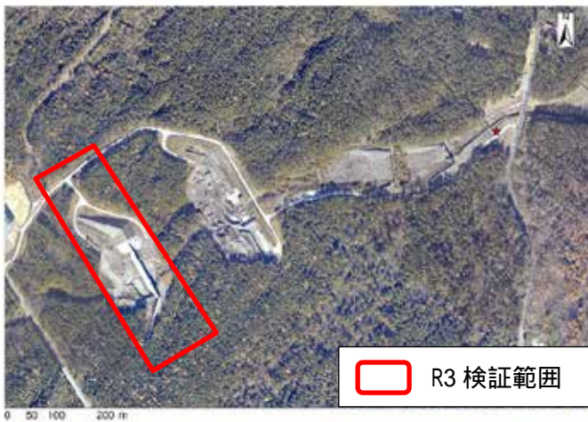
図-1 現地検証位置（浅間山山麓片蓋川）
