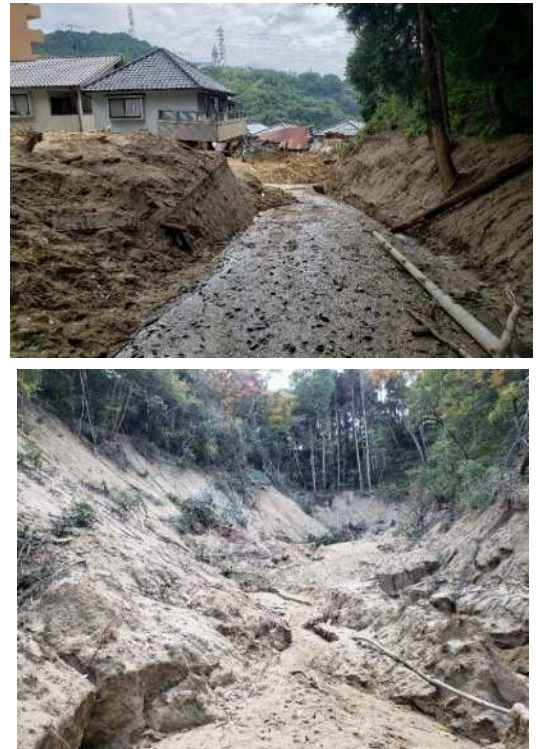
図-2 土砂災害氾濫開始点と崩壊発生部
