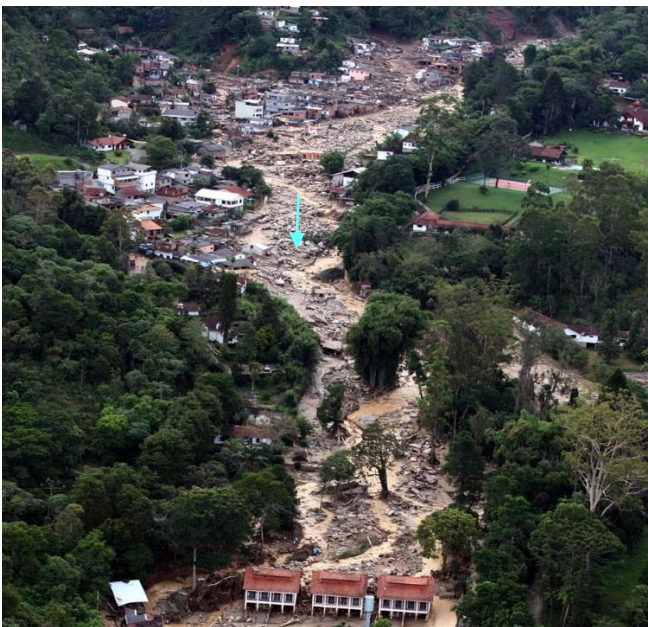
図-1 テレゾポリス市プリンシペ川の土石流災害
