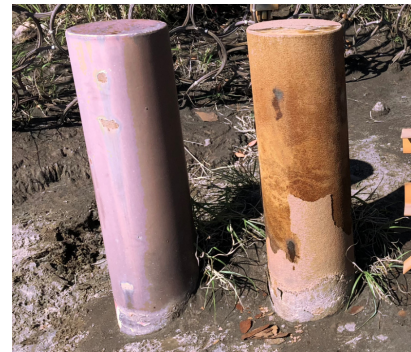
写真1 火山地帯の腐食状況 (左: 塗装、右: 無塗装)
