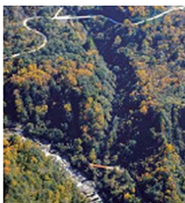
泥谷砂防堰堤群（「常願寺川砂防施設（泥谷堰堤）」）
