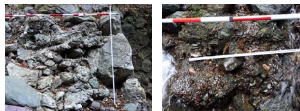
写真2 練石積堰堤(粗石コンクリート比較)
