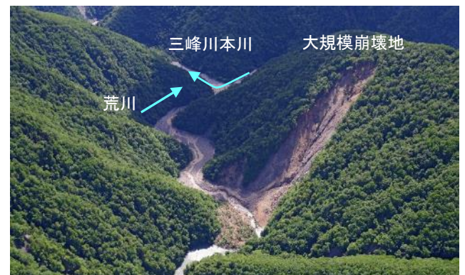
図3 大規模崩壊地付近の斜め写真
