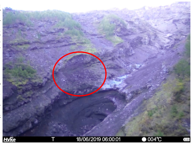
図4 インターバルカメラで確認した崩壊の発生状況
