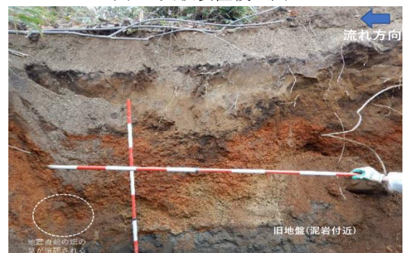
図-2 トレンチ掘削での崩土-旧地盤境界
