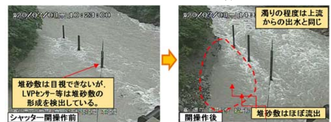
図-4 2020.7.8 出水(シャッター閉→水位 5.75m→開操作)
