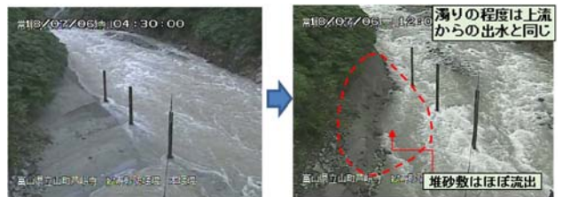
図-3 2018.7.5 出水(シャッター未操作)
