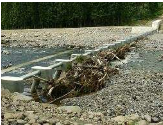
写真-1 不透過型砂防堰堤の流木捕捉状況 4)
