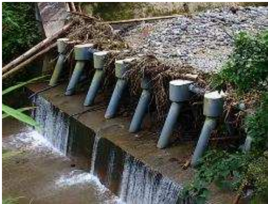
写真-2 流木対策施設による流木捕捉状況 5)
