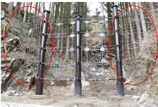
図-1 提案されている二次製品による小規模溪流対策事例 7)
