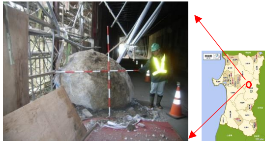
写真1 国道341号で発生した落石災害
