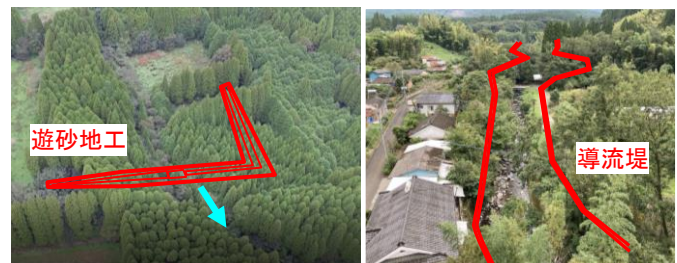
図-2 現地状況写真
