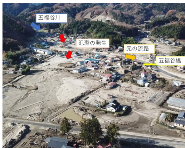
図-1 五福谷川の氾濫状況（2019年12月5日撮影）
