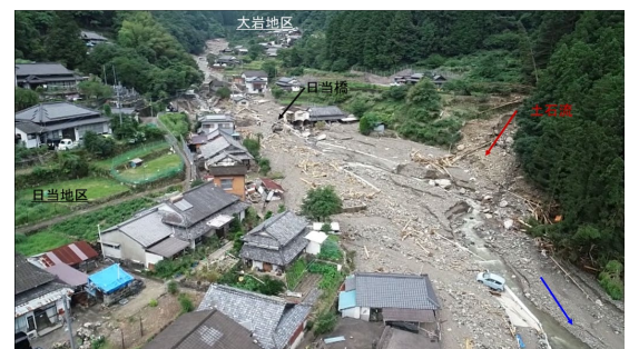
図-5 日當地区～大岩地区の土砂堆積状況
