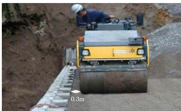
写真-2 振動ローラによる壁面際締固め状況
