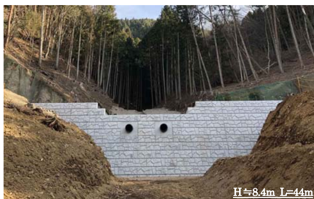
写真-6 下流面全景 (1期工事が終了時)
