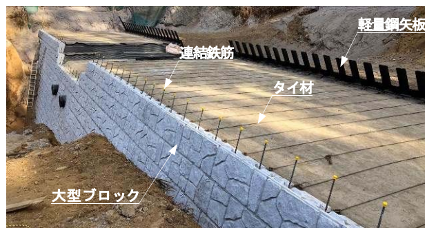
写真-3 タイ材と壁面材による中詰 INSEM の外部拘束補強
