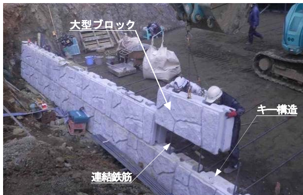
写真-1 大型ブロックの設置状況
