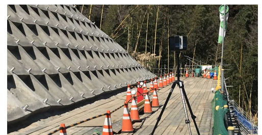
写真－1 地上型レーザースキャナ計測状況
