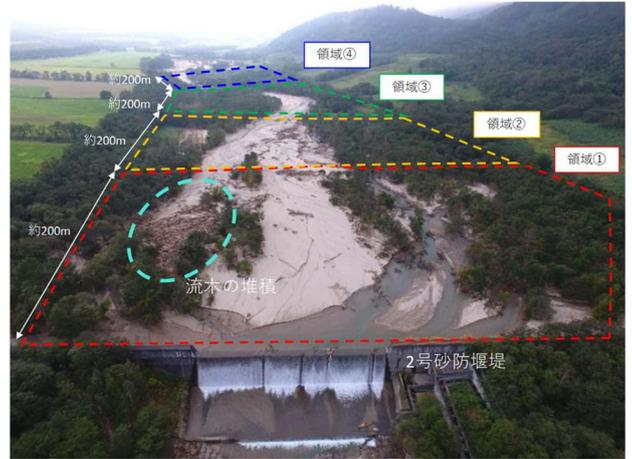
図-1 ペケレベツ川 2号砂防堰堤の堆積状況
