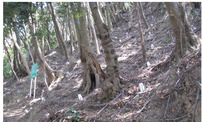
図1 対策工施工斜面の状況
