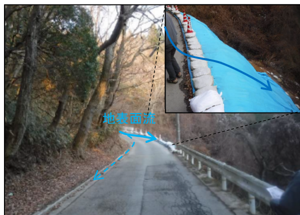
図 3 崩壊事例①（道路谷側斜面の崩壊）
