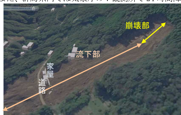
図-2 相模原市緑区牧野地区の斜面崩壊 (Google Earth, 2019年11月1日の画像)
