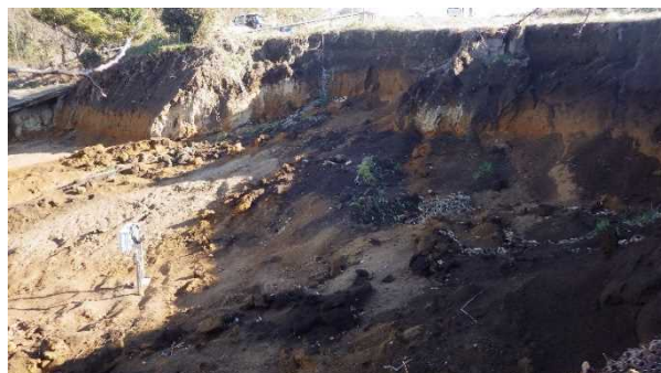
図-6 富岡市内匠地区斜面崩壊 (南側) の頭部
