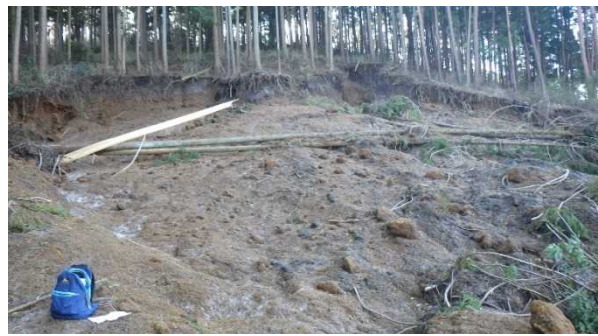
図-4 相模原市緑区上青根地区斜面崩壊の頭部
