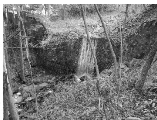
写真-1 堰堤全景
