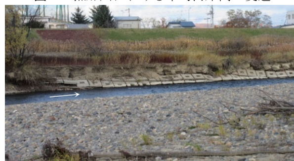
写真-1 河床低下による低水護岸損壊 (KP3.4付近)
