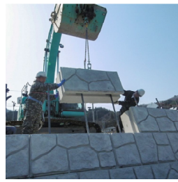
図-3 上下流壁面への大型積みブロックの使用
