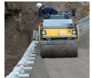
図-3 上下流壁面への大型積みブロックの使用
