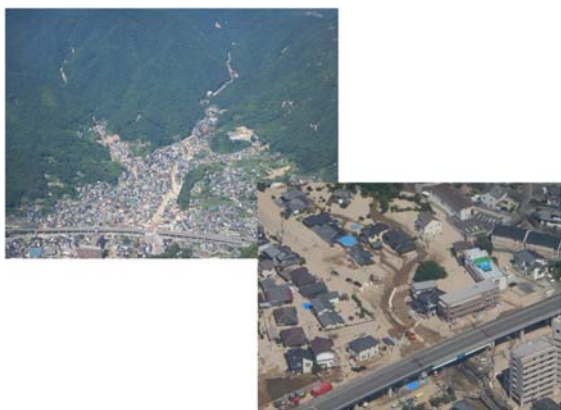
写真1 西日本豪雨による呉市天応地区の被害の様子
