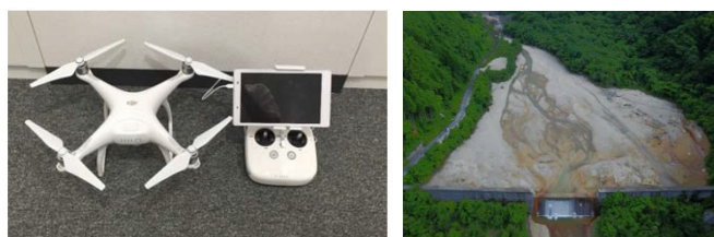
図-4 一般的な小型ドローンの概要と砂防堰堤における堆砂状況
