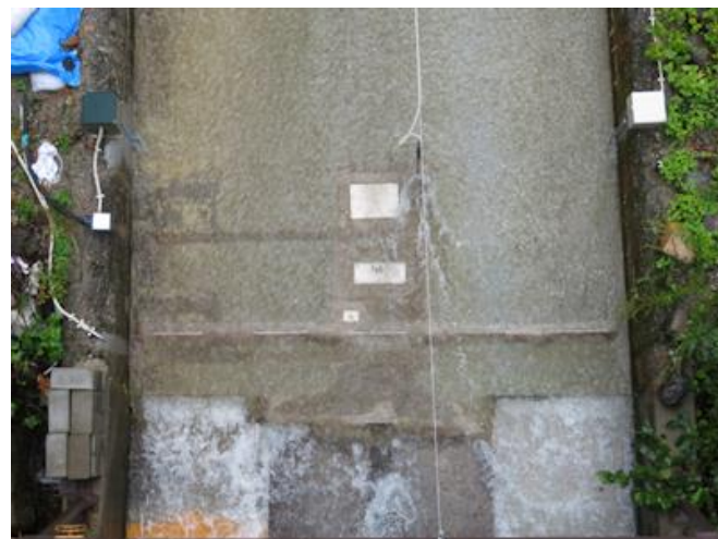
図-1 足洗谷観測水路におけるハイドロフォン設置状況
