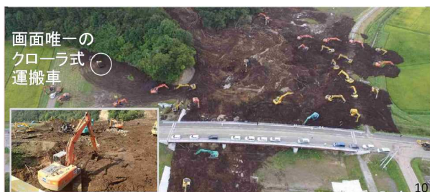
図-3 幌内橋周辺の河道閉塞土砂の除去状況 （北海道開発局 hp 平成 30 年北海道胆振東部地震に係る復旧・復興等の状況から引用）
