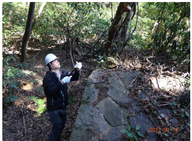
写真 2 堰堤の撮影状況
