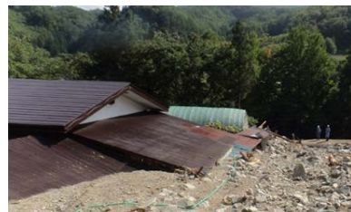
写真 2 土石流に屋根まで埋没した家屋(原形は留めている)
