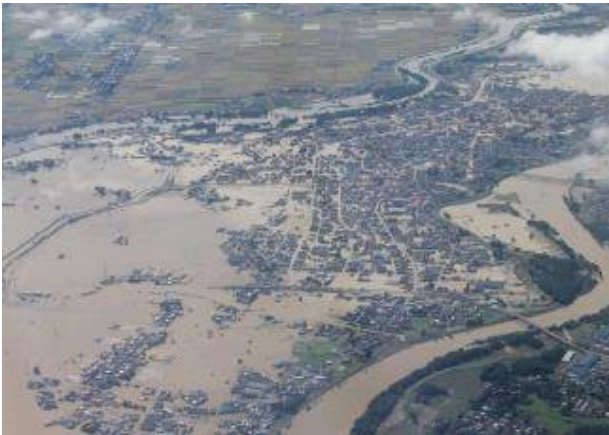
図-1 鬼怒川の浸水被害(平成 27 年 9 月,常総市) 出典;国土交通省関東地方整備局
