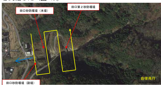
図-1 調査対象箇所
