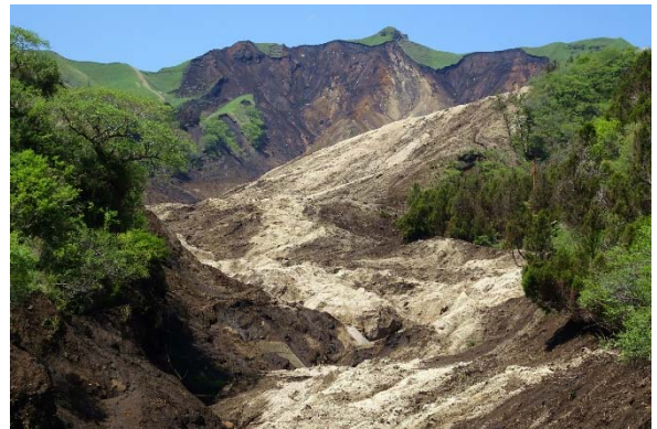
写真 4. 南阿蘇村内早川地区の山腹崩壊地
